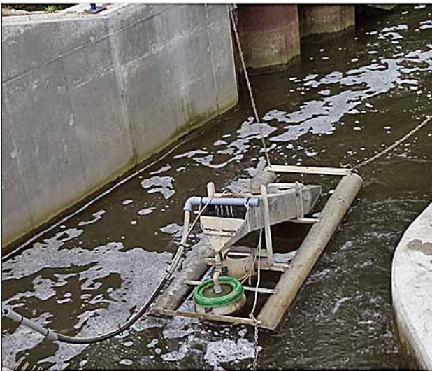
Abb. 1 Schwimmende Aalrinne in Wismar, die vor der Auf- und Abstiegshilfe installiert ist.
