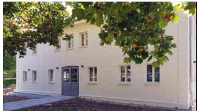
Abb. 1: Unter Denkmalschutz stehender saniertes Kopfbau am FischGlasHaus.
